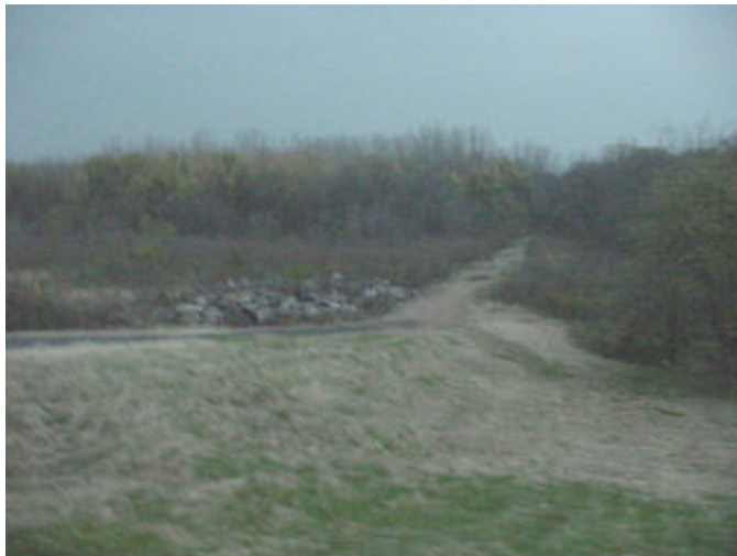
21. Ramp over levee.
